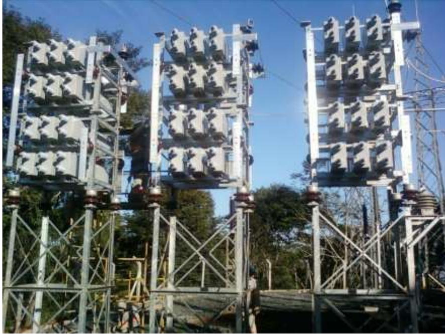
Figura 2 – Banco de capacitor de 3.600 kVAr em 13.800 V
