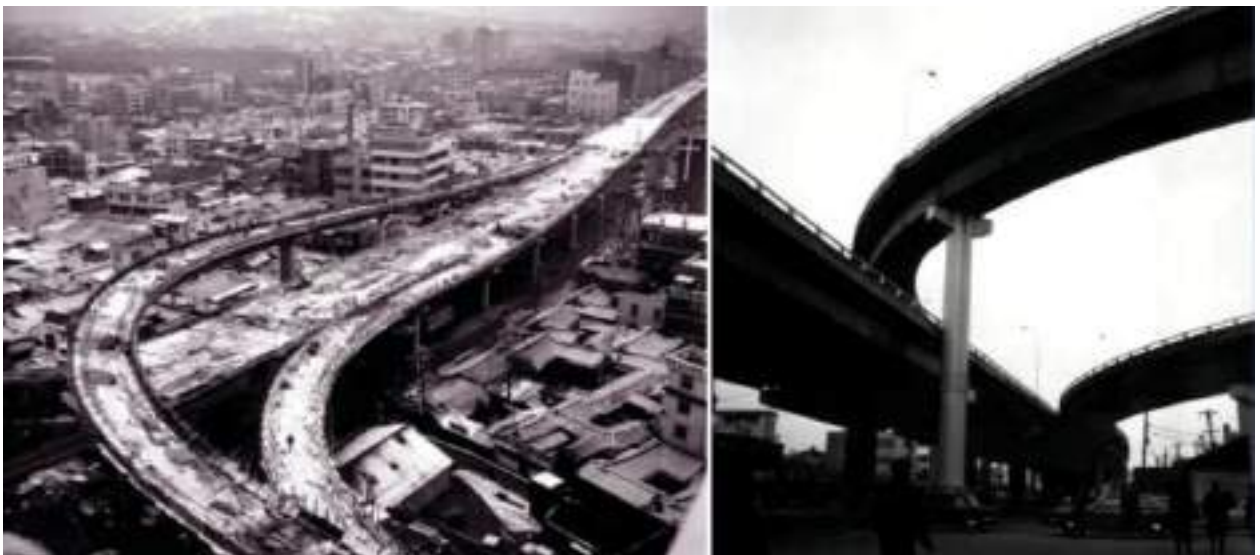
FIGURA 15 – VIAS E VIADUTO COM PISTAS DE ALTA VELOCIDADE CONSTRUÍDAS SOBRE O RIO CHEONGGYECHEON
