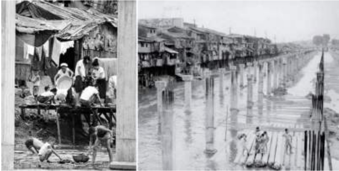
FIGURA 14 – SITUAÇÃO DO RIO CHEONGGYECHEON NO INÍCIO DO XX E OBRAS DE FECHAMENTO E OBRAS DE FECHAMENTO EM MEADOS DO XX
