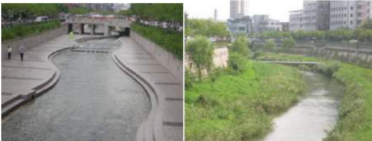
FIGURA 22 – TRECHO MAIS A MONTANTE (ESQUERDA) E A JUSANTE (DIREITA) DO RIO (INCLUÍDOS NO PROJETO)
