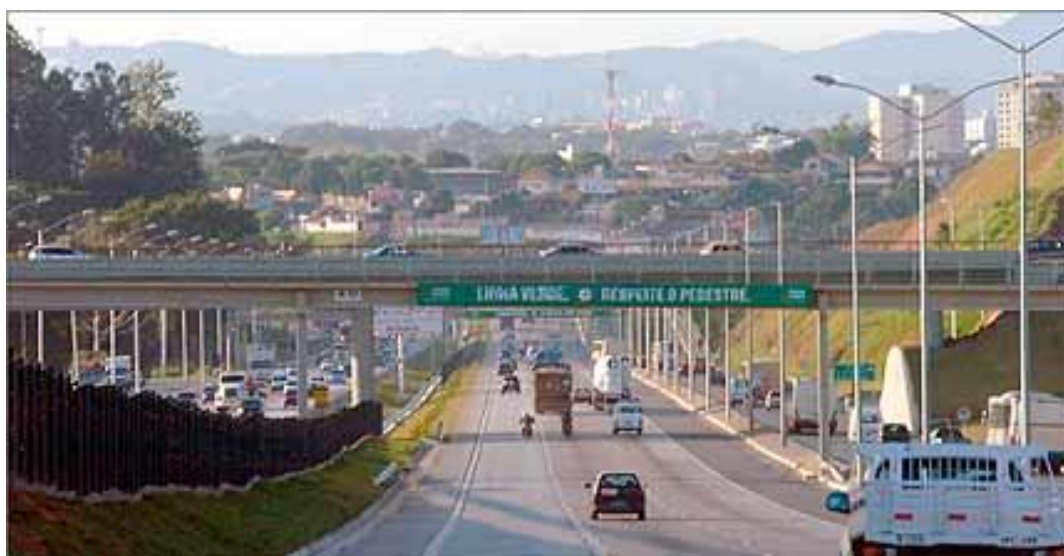
FIGURA 39 – MG 010 DEPOIS DAS OBRAS
