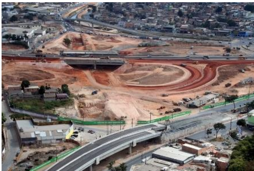
FIGURA 38 – AV CRISTIANO MACHADO – OBRAS EM ANDAMENTO
