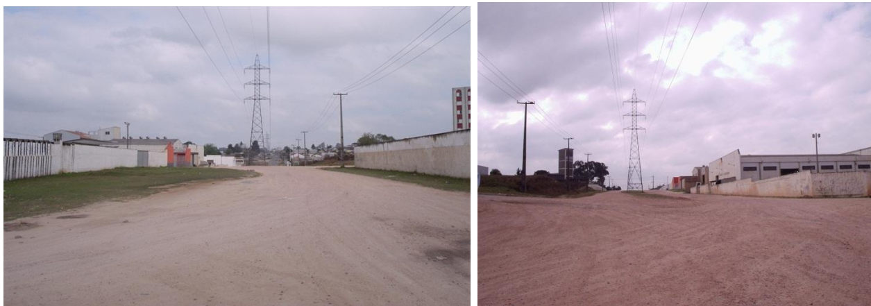
FIGURAS 80 E 81 – AVENIDA DAS TORRES APÓS A BIFURCAÇÃO COM A BR 376 ANTES DO PROJETO DE PAVIMENTAÇÃO E DRENAGEM. TRECHO ENTRE RUA PALMEIRA E IZABEL A REDENTORA, 2004
