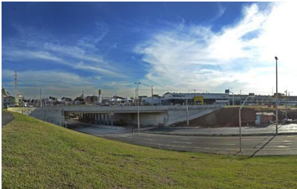
FIGURA 84 – TRINCHEIRA MINISTRO AFFONSO CAMARGO NO CRUZAMENTO DA AVENIDA DAS TORRES E AVENIDA RUI BARBOSA
