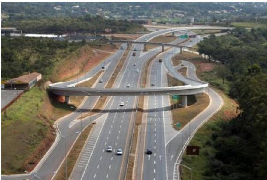
FIGURA 40 – MG 010 DEPOIS DAS OBRAS
