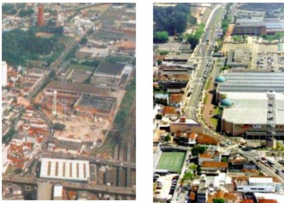
FIGURA 24 e 25 – AVENIDA INDUSTRIAL ANTES E DEPOIS DA INTERVENÇÃO DO ABC PLAZA SHOPPING
